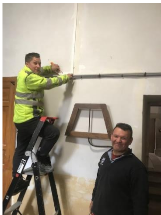
Remise aux normes électricité sacristies de l'église
