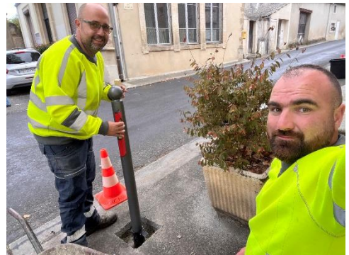
Mise en place des balises de
